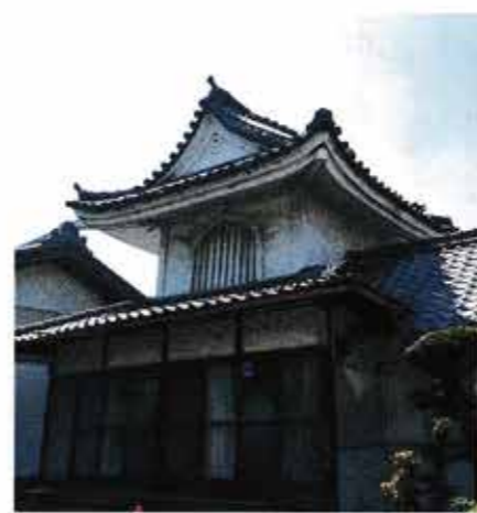
◀ 修復前の太鼓楼
