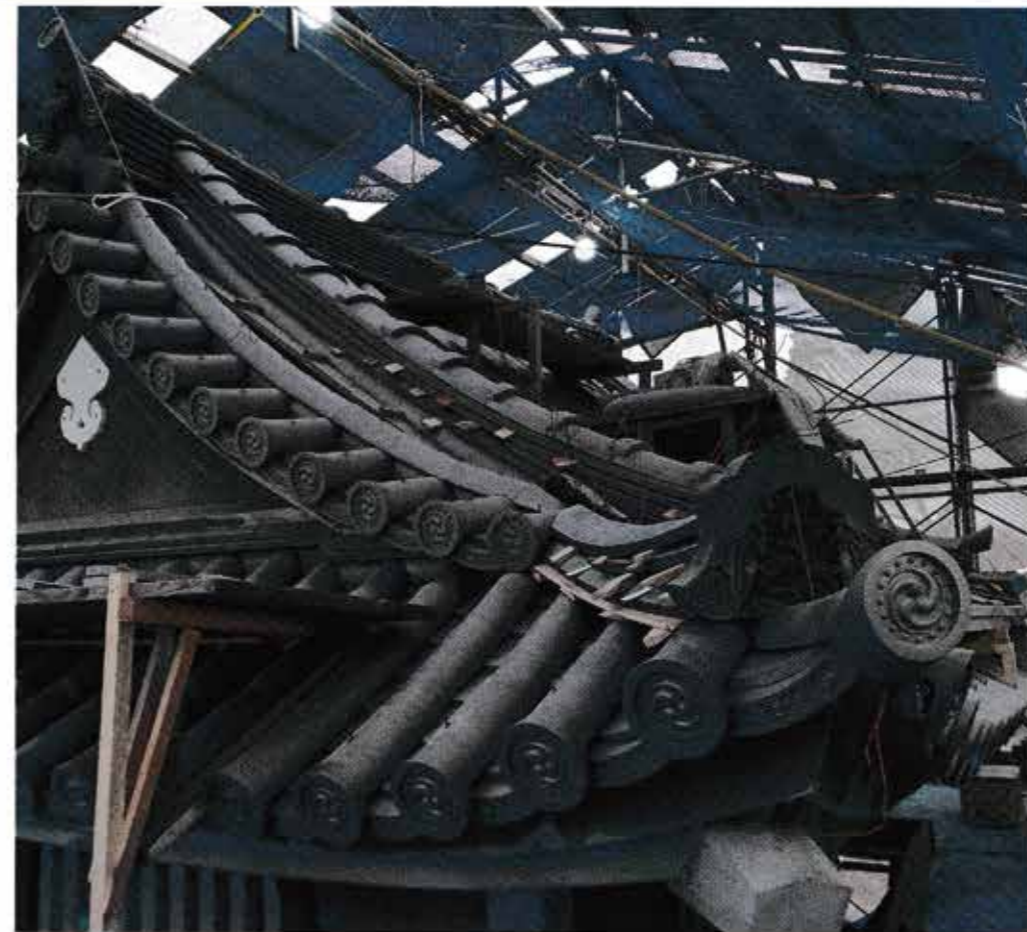
▲ 完成間際の太鼓楼
