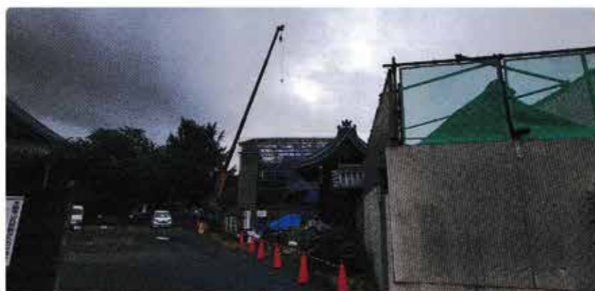
▲ クレーンを使って屋根瓦をおろす風景
