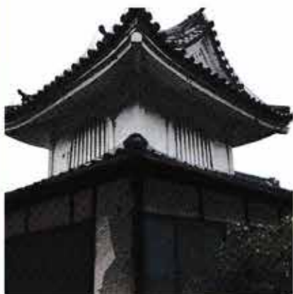
▲ 修復前の太鼓楼
